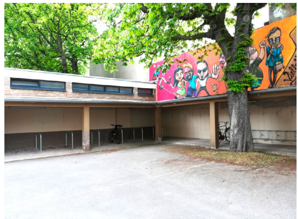
Schulhof vorher, Foto Büro S+W
