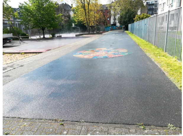
Schuhof vorher O-Hof, Foto Büro S+W
