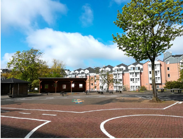
Schuhof vorher O-Hof, Foto Büro S+W
