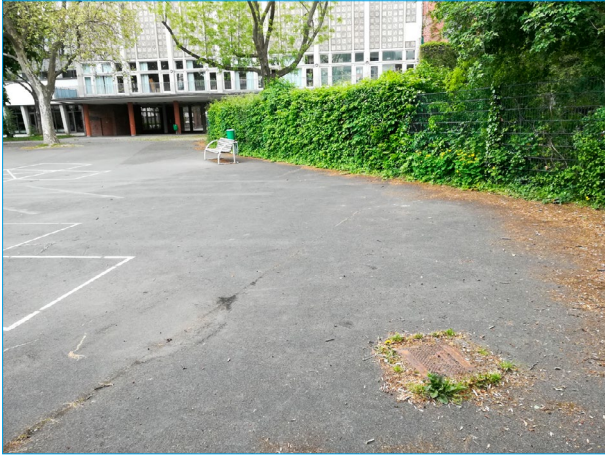
Schulhof vorher, Foto Büro S+W
